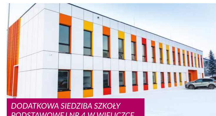
BUDOWA PRZEDSZKOLA W ZABAWIE
